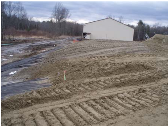
ACS cap - Fill placement
