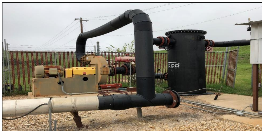
Figura 10. Estación de soplación y cárcamo de condensado típica
