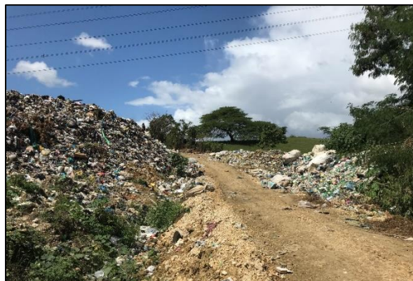
Sección del camino de acceso actual mostrando basura v drenaje deficiente.
