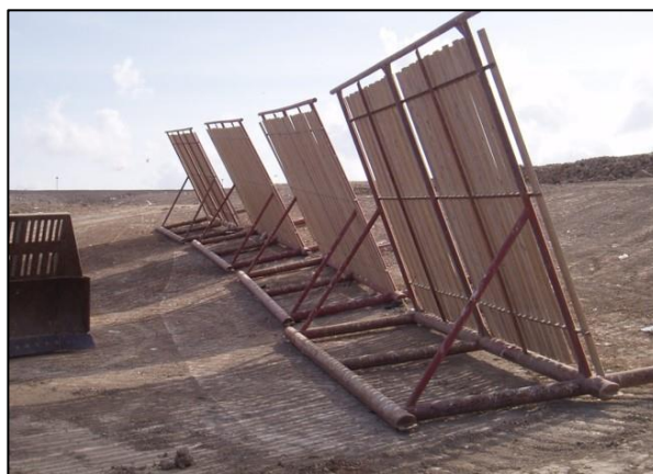
Mejor Práctica: Las cercas portátiles se pueden mover diariamente al frente de trabajo y estar posicionadas conforme a la dirección actual del viento.
