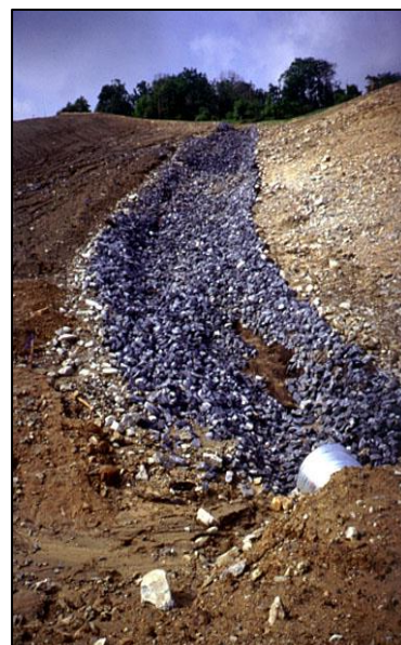
Mejor Práctica: Control adecuado de aguas pluviales minimizan la erosión.
