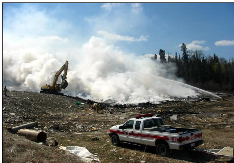
Mejor Práctica: Retro-excavadora volcando desechos en combinación con la aplicación de agua.
