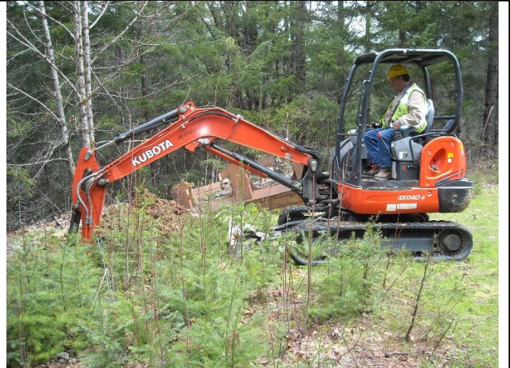
Excavating Test Pit Using Mini Excavator
