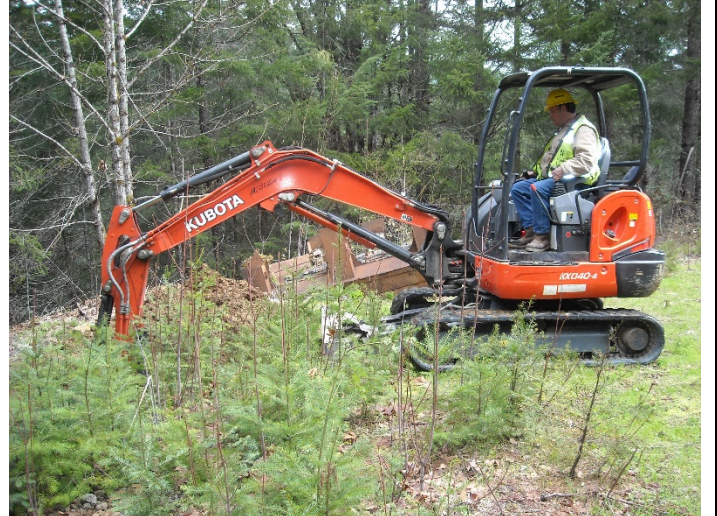
Excavating Test Pit Using Mini Excavator
