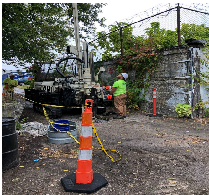
Los contratistas de la EPA utilizaron una máquina Geoprobe para instalar pozos de monitoreo cerca del sitio.
