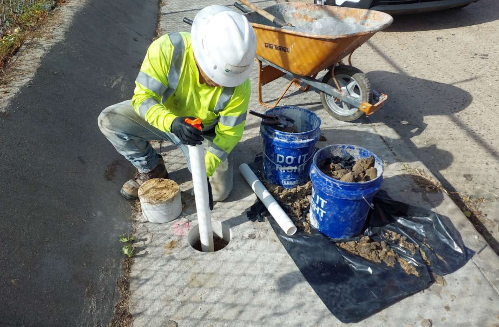
Instalación de pozo para monitoreo de aguas subterráneas Liberty Rd
