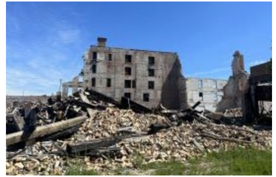
La foto de arriba es una vista hacia el norte del edificio derrumbado en el lugar. Después del incendio queda una gran pila de escombros de construcción contaminados con asbesto.
