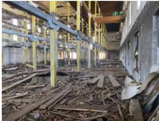
La foto de arriba es una vista hacia el norte del edificio derrumbado en el lugar. Después del incendio queda una gran pila de escombros de construcción contaminados con asbesto.
