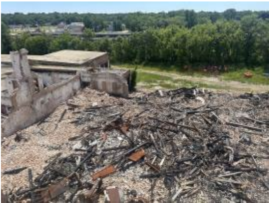
La foto de arriba muestra una gran pila de escombros de construcción contaminados con asbesto como resultado del incendio.
