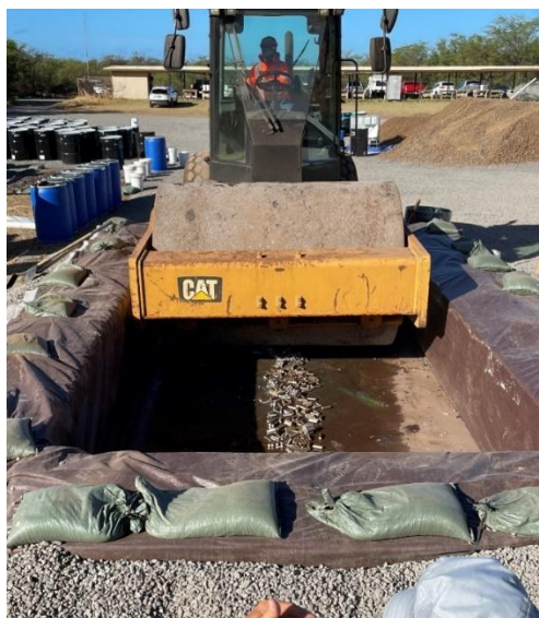
Figura 15. Fotografía de una operación de desmantelamiento en curso.
