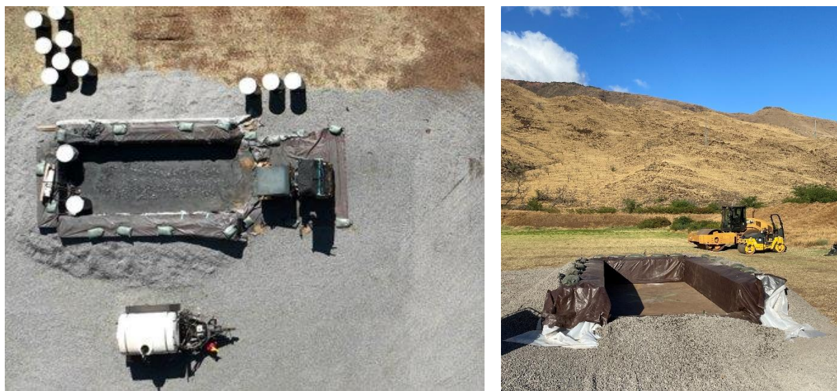
Figura 13. Ejemplo de distribución de un área de desmantelamiento mediante aplastamiento.
