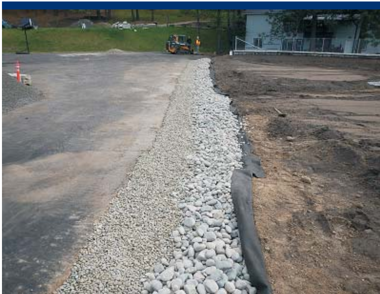
Photo 67 Final drain rock apron.
